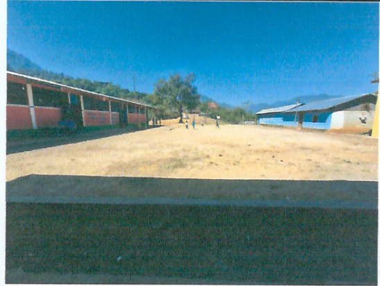
Foto 2: MEJORAMIENTO MODULO 11 (PATIO DEL ESTABLECIMIENTO), LOSA DE PATIO
