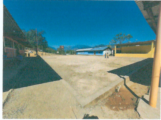
Foto 2: MEJORAMIENTO MODULO 11 (PATIO DEL ESTABLECIMIENTO), PORTICO, CUBIERTA DE LAMINA
