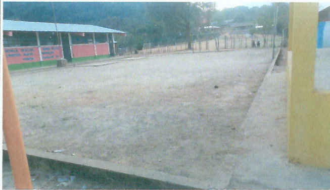
Foto 3: MEJORAMIENTO MODULO 11 (PATIO DEL ESTABLECIMIENTO), PORTICO, CUBIERTA DE LAMINA
