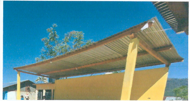
Foto 2: MEJORAMIENTO MODULO 5 (ESCENARIO), CUBIERTA DE LAMINA
