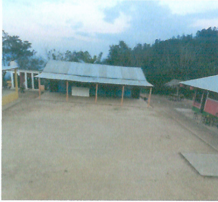
Foto 1: MEJORAMIENTO MODULO 11 (PATIO DEL ESTABLECIMIENTO), PORTICO, CUBIERTA DE LAMINA
