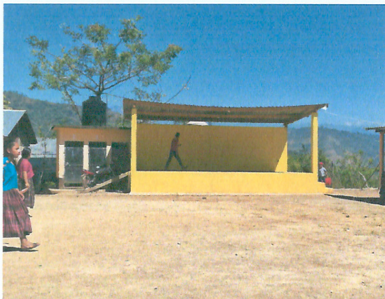
Foto 3: MEJORAMIENTO MODULO 5 (ESCENARIO), ESTRUCTURA DE TECHO
