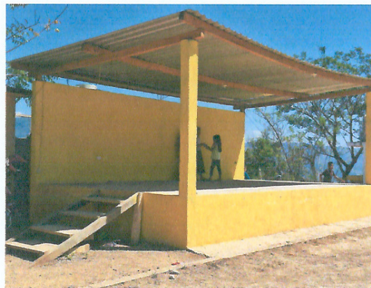
Foto 4: MEJORAMIENTO MODULO 5 (ESCENARIO), ESTRUCTURA DE TECHO
