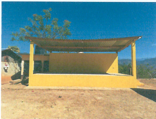
Foto 1: MEJORAMIENTO MODULO 5 (ESCENARIO), ESTRUCTURA DE TECHO
