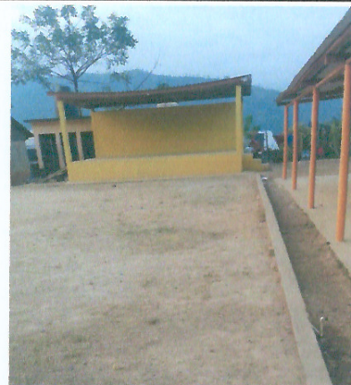
Foto 4: MEJORAMIENTO MODULO 11 (PATIO DEL ESTABLECIMIENTO), LOSA DE PATIO
