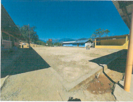
Foto 1: MEJORAMIENTO MODULO 11 (PATIO DEL ESTABLECIMIENTO), LOSA DE PATIO
