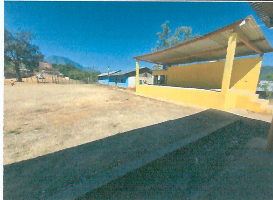
Foto 2: MEJORAMIENTO MODULO 5 (ESCENARIO), ESTRUCTURA DE TECHO
